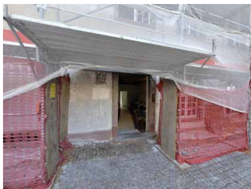
Durch das Gerüst in den Vorraum der Oekumenischen Medienverleihstelle.
